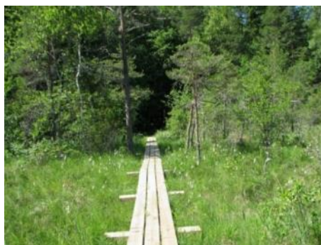
34.att. Izbūvēta jauna laipa, lai apmeklētāji var šķērsot purvu (2013) 17
