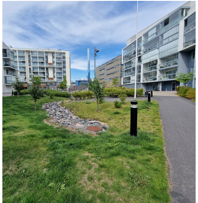
Teritorijā izmantotas ilgtspējīgas lietusūdens savākšanas sistēmas (autoru foto)
