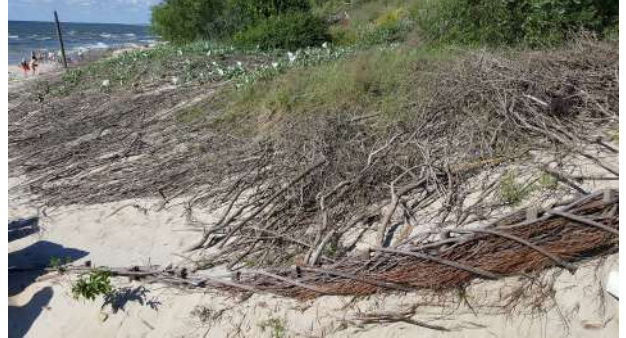
Medienos naudojimas kranto sutvirtinimui
